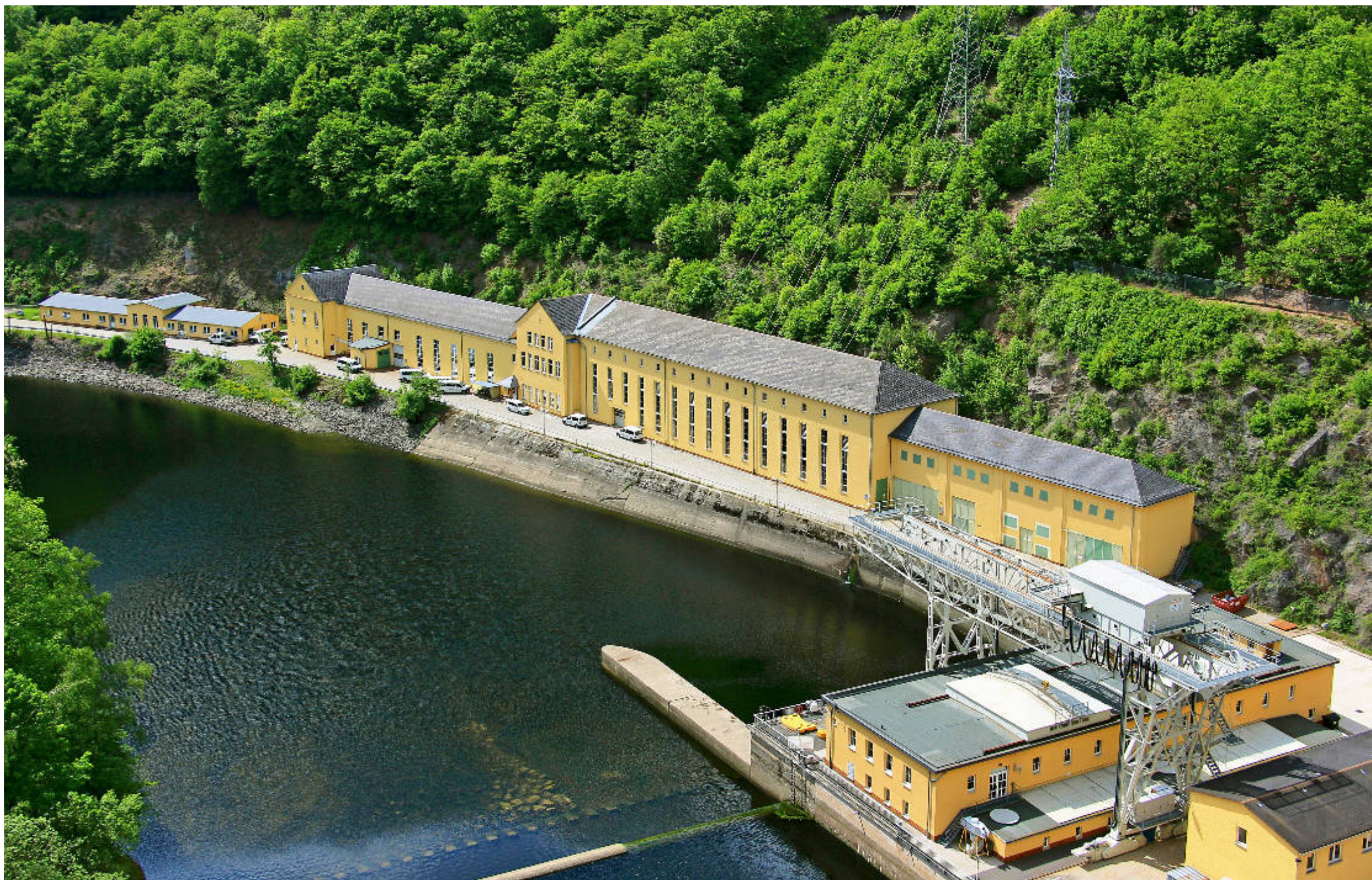
An der riesigen Staumauer bei Hohenwarte, einer Talsperre zur Energiegewinnung und deren Speicherung, geht der Blick über das Gebiet des „Thüringer Meeres“ oder flussabwärts 75 Meter in die Tiefe.
